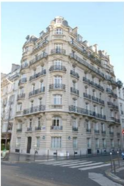
DP 6.1 - Photo du projet (Les antennes sont invisibles depuis ce point de vue)
