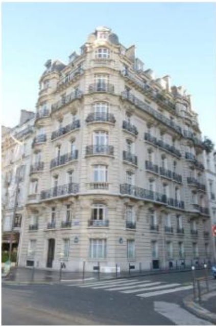
DP 7.1 - Photo de l'existant
