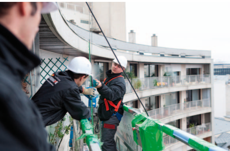
Condominium "Fontaine d'Aligre", replacing windows © Jean-Baptiste Gurliat, Ville de Paris
