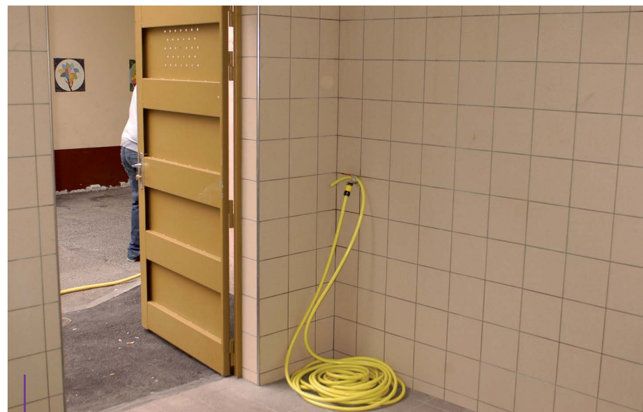
Point d'eau près du local propreté
