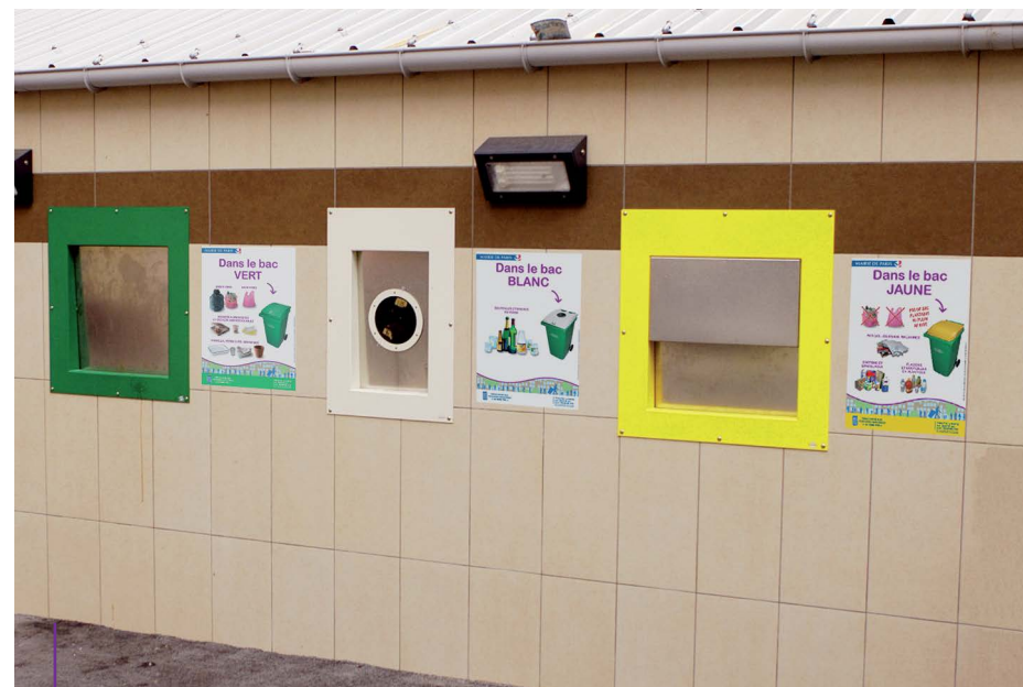
Aménagement avec trappes et signalétique
