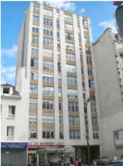
DP 7.1 - Photo de l'existant
