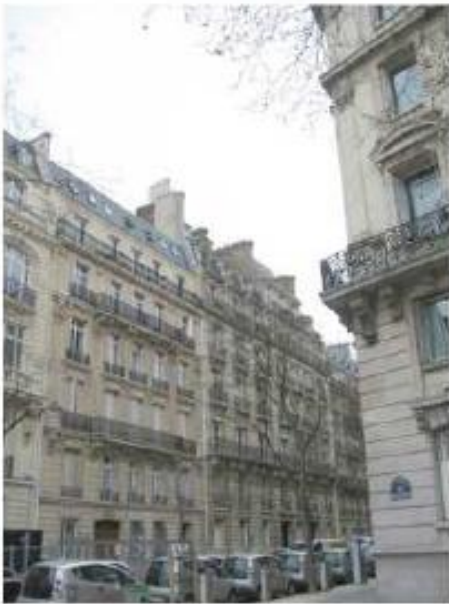
DP 7.1 - Photo de l'existant
