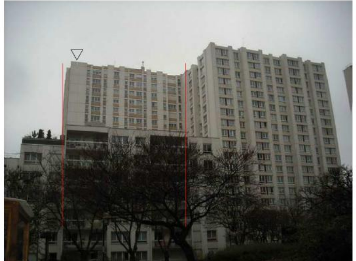
DP 8 - Photo de l'existant, vue lointaine
