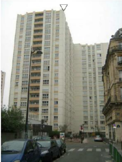
DP 7.1 - Photo de l'existant
