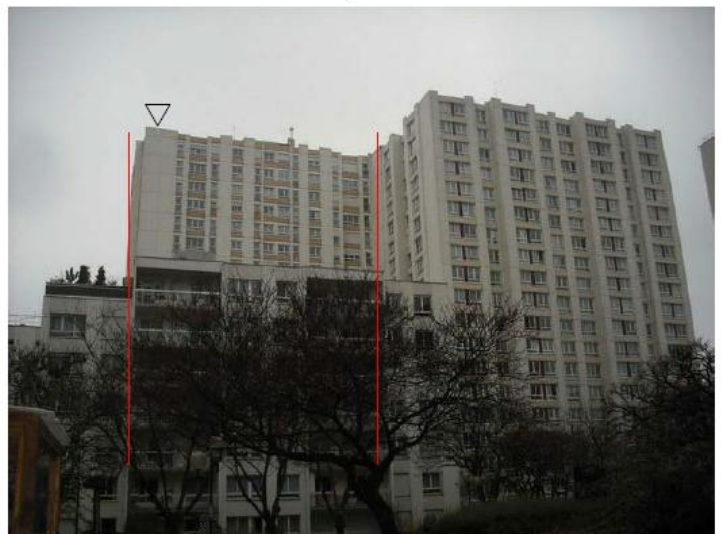
DP 8 - Photo du projet, vue lointaine
