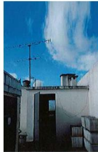
EMPLACEMENT AVANT TRAVAUX
