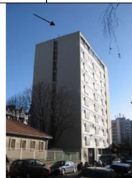
PHOTO DEPUIS LA RUE AVANT TRAVAUX
