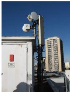
PHOTO DEPUIS LA RUE AVANT TRAVAUX
