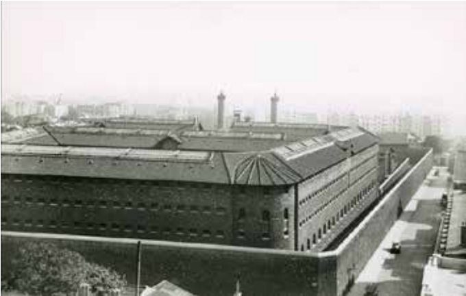
Vue à vol d'oiseau vers 1930 en direction du nord (© Albert Harlingue / Roger-Viollet). Les bâtiments ont déjà été surélevés d'un étage.
