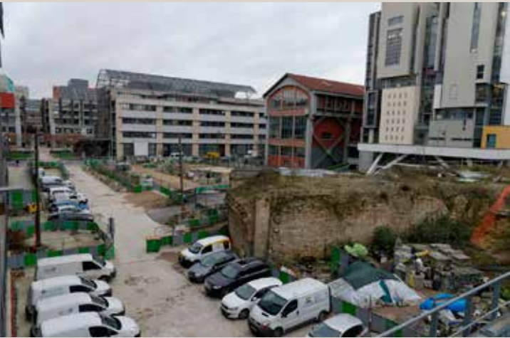
Vue du terrain depuis le boulevard. Le terrain est traversé par l'extrémité du viaduc du raccordement de l'ancien chemin de fer de ceinture aux voies de la gare d'Asuterlitz.
