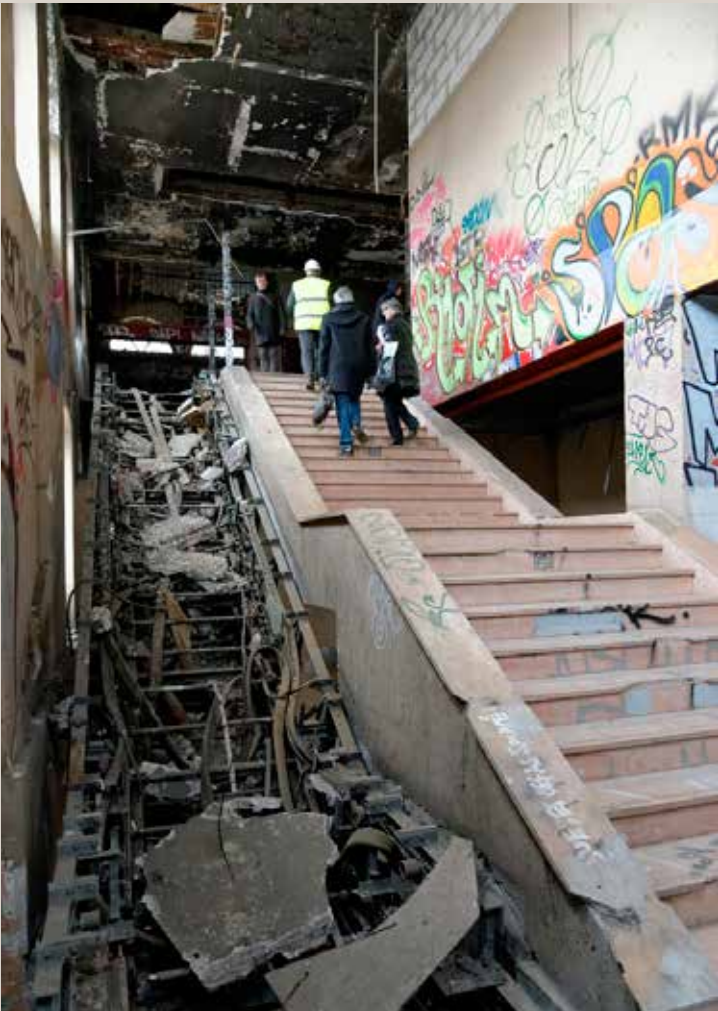
Vue actuelle, à l'intérieur de la gare, des vestiges de l'accès au RER.
