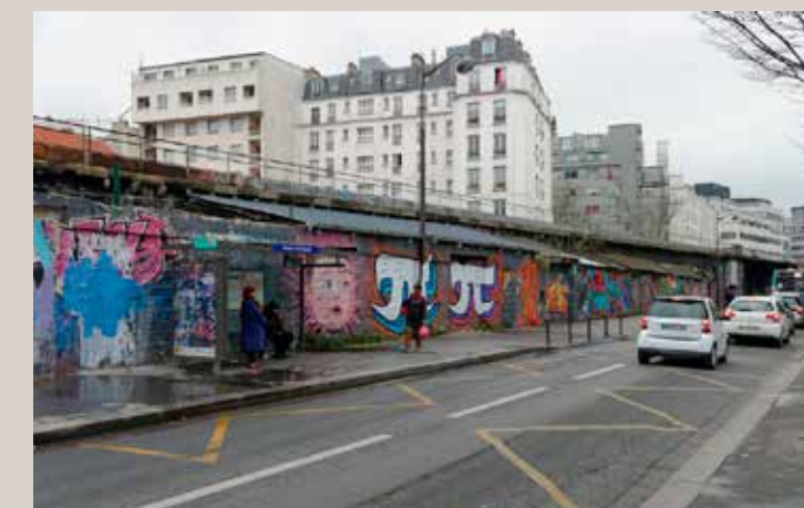
Vue actuelle du viaduc de l'Argonne, sur la rue de l'Ourcq.
