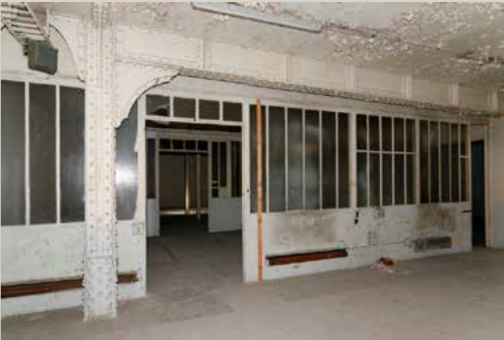
Vue des cloisonnements des niveaux supérieurs.
