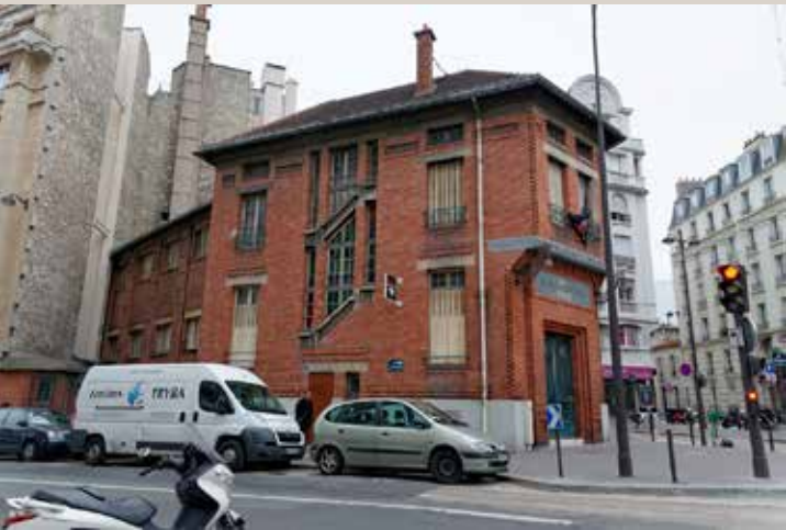
Vue actuelle sur la rue Saint-Amand. Au centre, les baies de l'escalier principal.
