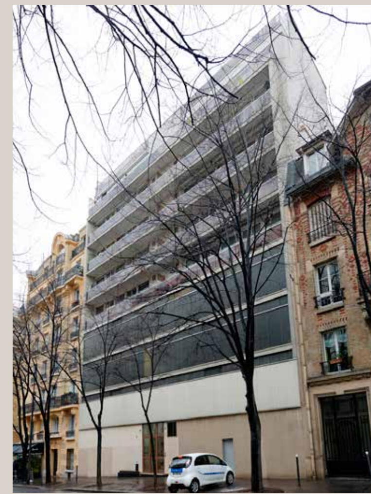
Façade actuelle sur l'avenue Gambetta.
