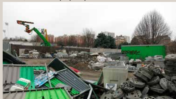
Vue actuelle du dépôt de matériaux depuis le sud en direction du cimetière.
