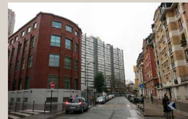
Vue actuelle de l'avenue Edison. Le terrain du projet se trouve au second plan, en rive gauche.
