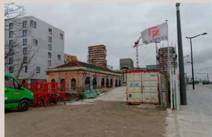
Vue actuelle de l'ancienne station Orléans-ceinture depuis le boulevard du Général-Jean-Simon montrant les travaux en cours d'extension du tramway.
