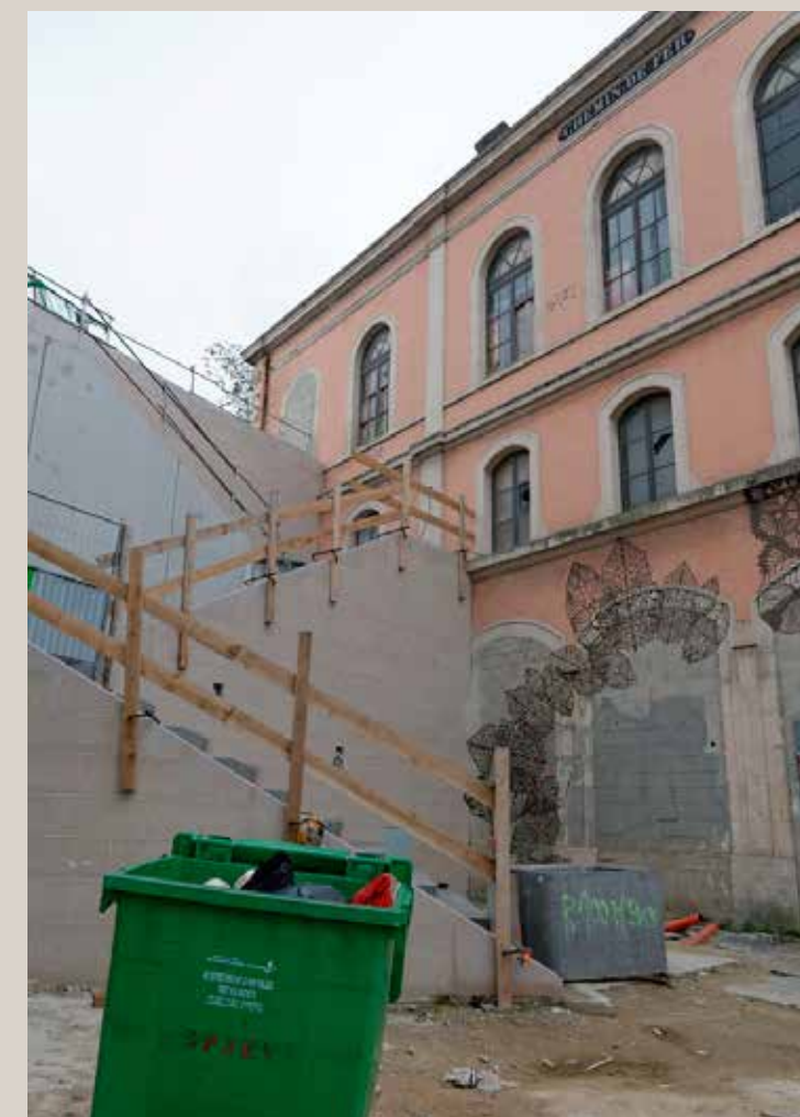
Vue du nouvel escalier public plaqué sur la façade ouest de la gare. La connexion avec les nouveaux aménagements prévoit de remonter d'une soixantaine de centimètres les planchers de la gare.
