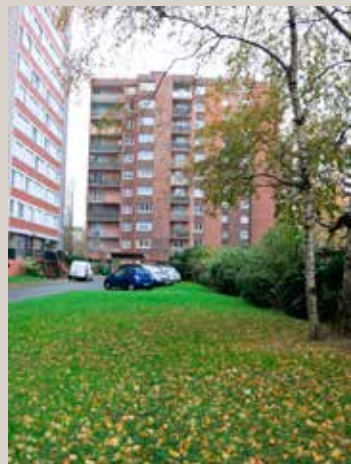
Vue actuelle des espaces à l’alignement sur la rue Curnonsky.
