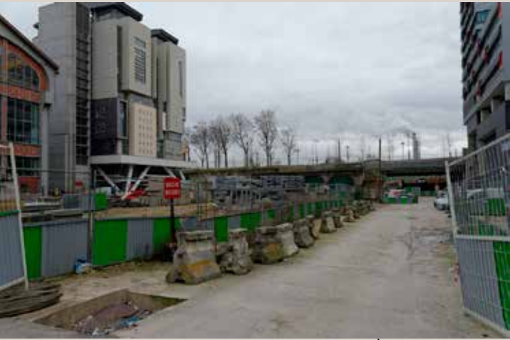
Vue du terrain depuis la rue Jean-Antoine-de-Baïf. À droite, la future allée vers Ivry.
