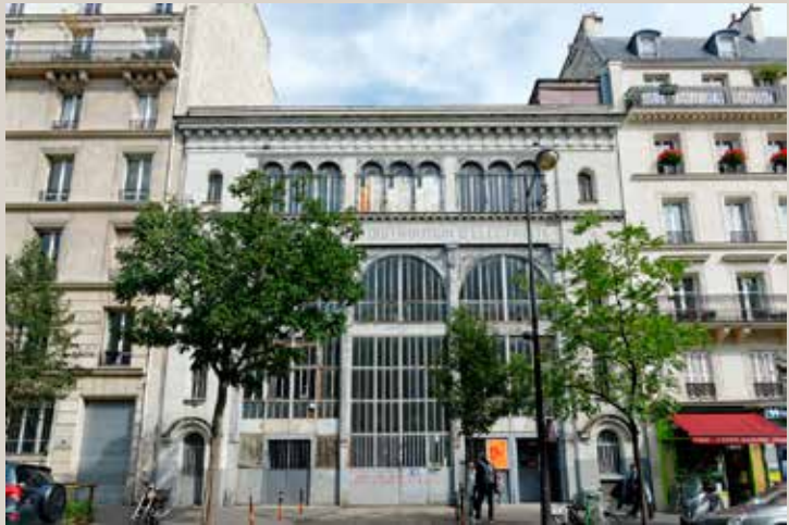
Façade actuelle de la sous-station sur l'avenue Parmentier.
