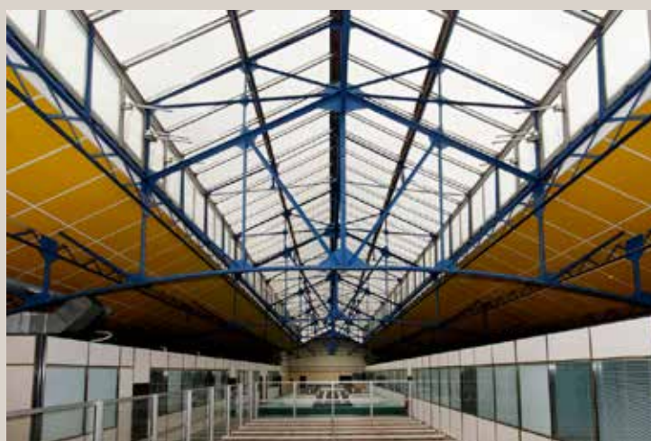
Vue de l'intérieur du hangar en 2011.
