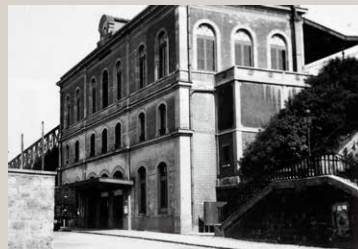
Vue de la gare depuis la rue Regnault (cliché non daté).
