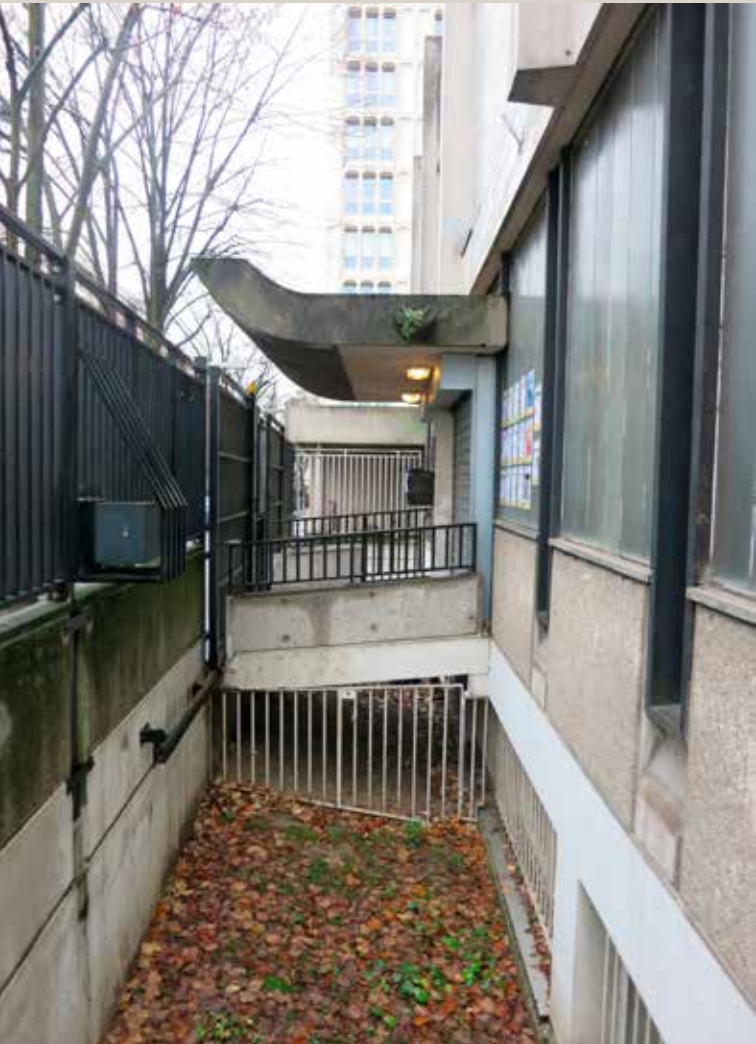
Détail de la cour anglaise et de l'auvent d'entrée sur la rue Albert Bayet.
