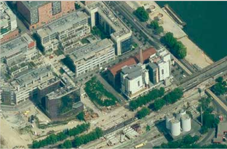
Vue aérienne du site. La parcelle concernée est délimitée par l'an-cienne usine de la SUDAC, le boulevard des maréchaux, la future allée d'Ivry et le « Biopark ».
