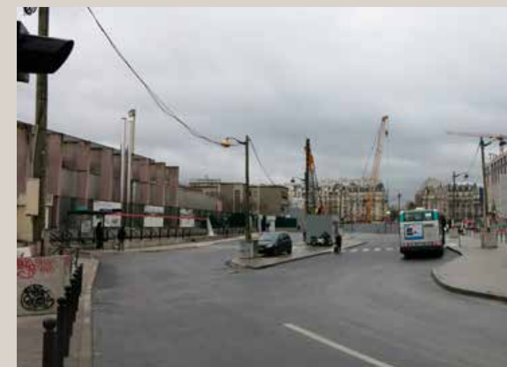
Site du projet, vers le sud.
