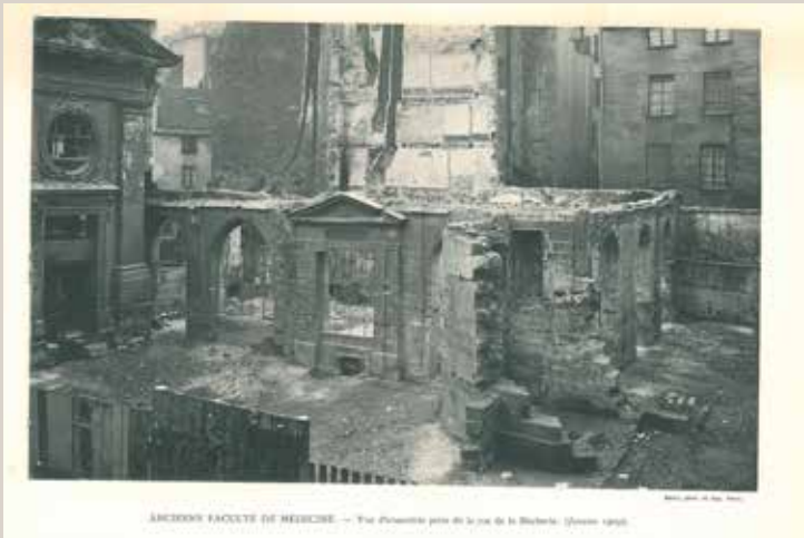
Vue de l'ancien bâtiment des écoles en janvier 1909 (photographie de Barry).
