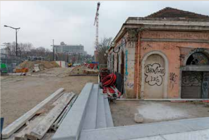
Vue de la gare depuis le haut de la rue du Loiret, depuis laquelle un accès au bâtiment serait aménagé sur un nouveau plancher.
