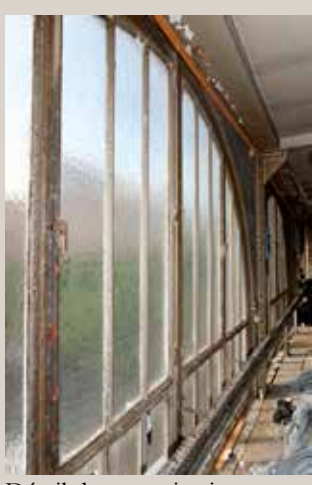
Détail des menuiseries métalliques sous les grandes arcades.
