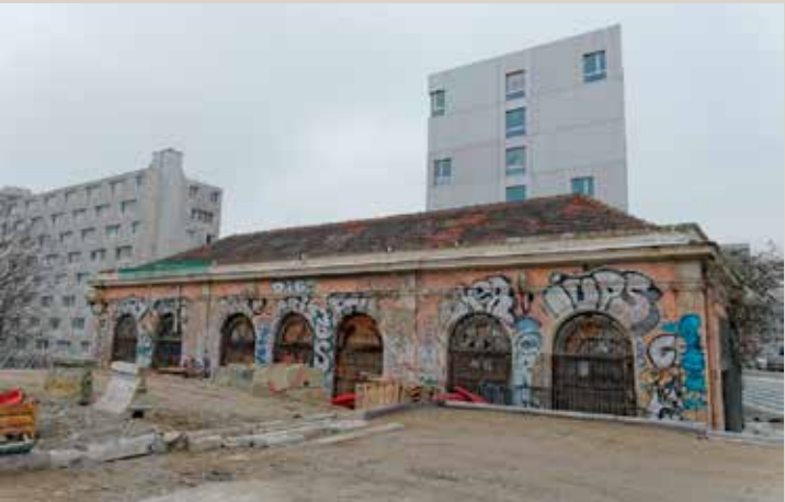
Vue actuelle de l'ancienne station Orléans-ceinture depuis le boulevard du Général-Jean-Simon montrant le niveau fini de la voirie.
