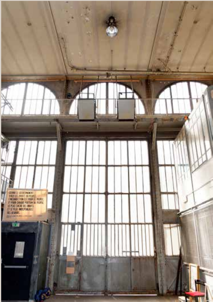
Vue actuelle, vers l'avenue, du volume principal à rez-de-chaussée.
