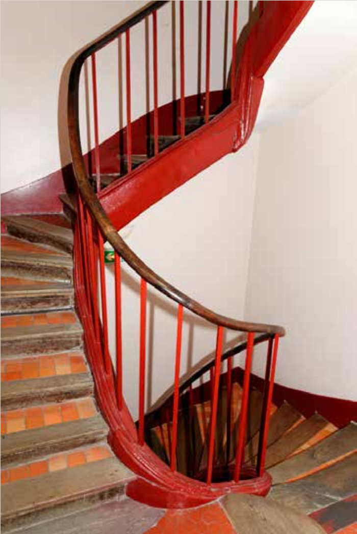
Escalier de service conservé à l'angle du logis principal et de l'aile gauche, non protégé.
