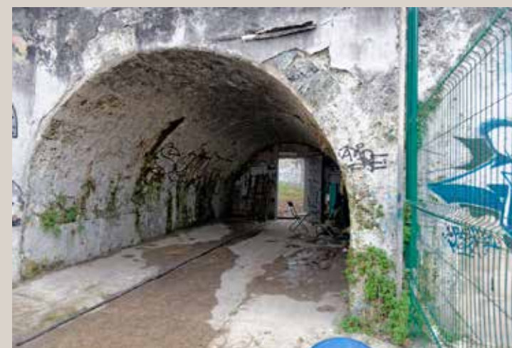
Volume de l'une des 15 arcades du viaduc de l'Argonne donnant accès à la partie arrière du terrain située le long de l'ouvrage ferroviaire de la petite ceinture.
