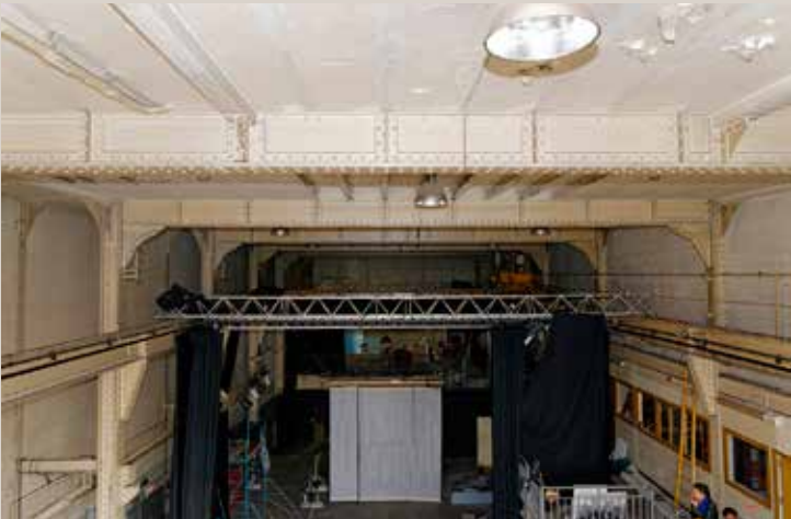
Vue actuelle du volume principal depuis la coursive.
