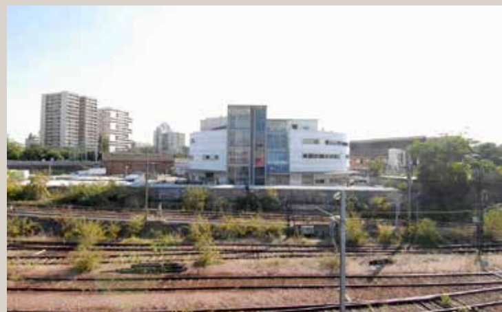
Vue du site en 2009 depuis les anciens entrepôts Macdonald montrant le bâtiment circulaire de 1990 devant la halle métallique, à droite.
