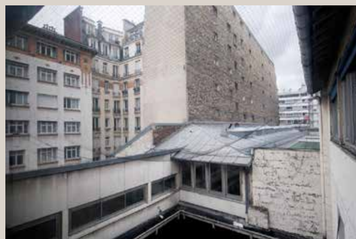
Vue en 2011 de la cour au premier plan et du hangar au second.
