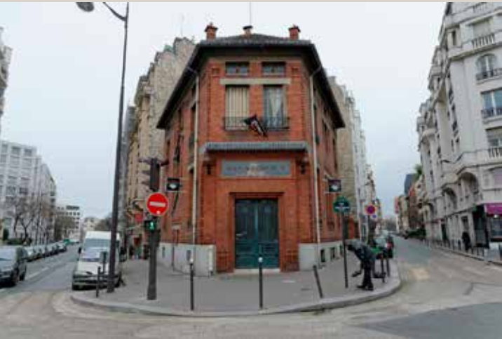
Vue actuelle de l'entrée des bains-douches sur la place du Général Monclar.
