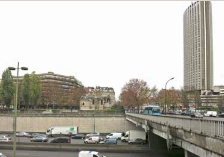
Vue actuelle de la tranchée du boulevard périphérique dont la couverture est envisagée. Au centre, l'église Notre-Dame-de-Compassion.
