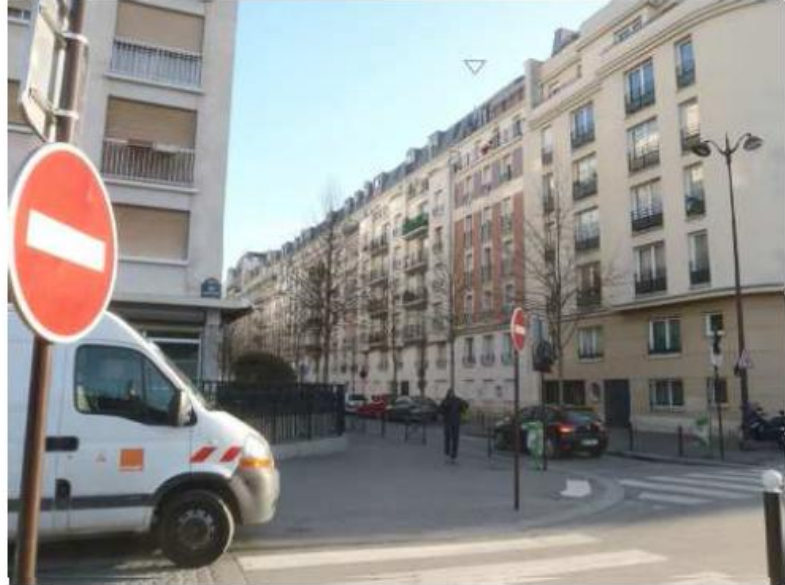
DP 8 - Photo de l'existant, vue lointaine
