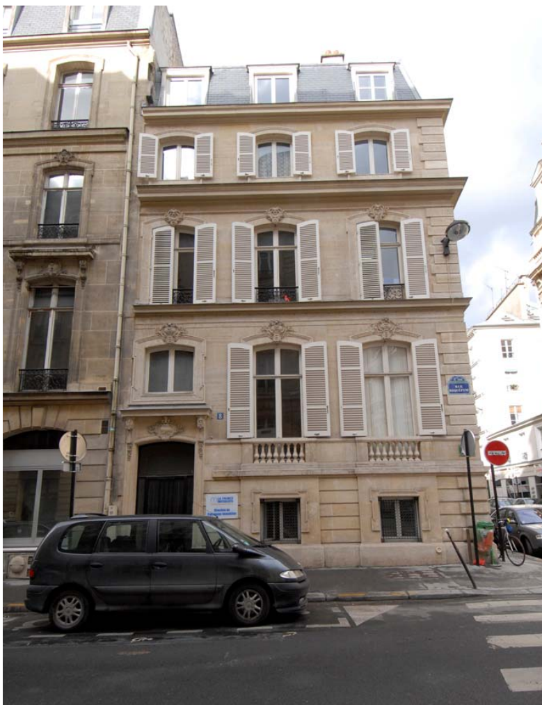
restructuration en 1992 (Franck Courtois de Vigose architecte) 21-23, rue d'Astorg construit en 1973-1977 (Jean-Claude Daufresne architecte)
