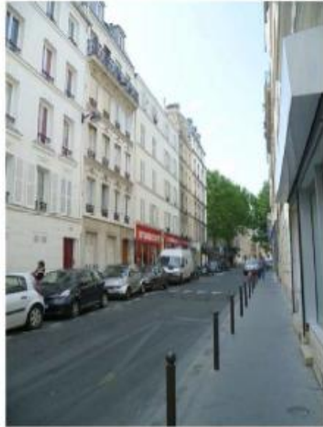
DP 8 - Photo de l'existant, vue lointaine
