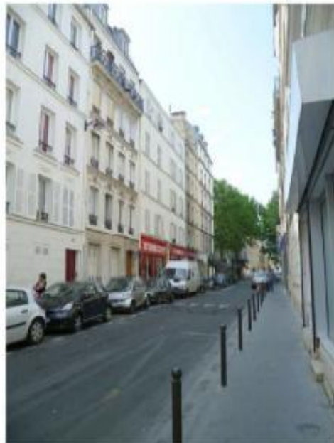
DP 8 - Photo du projet, vue lointaine (L'antenne n'est pas visible depuis ce point de vue)
