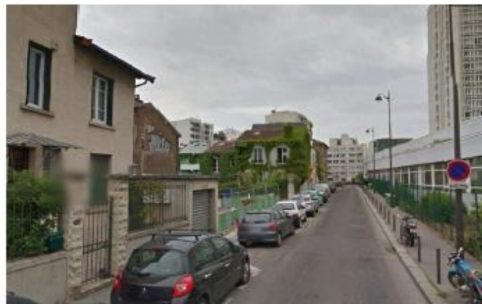
Photo Avant Travaux
