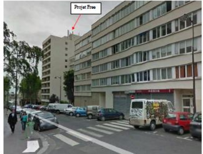
Photo Après Travaux
