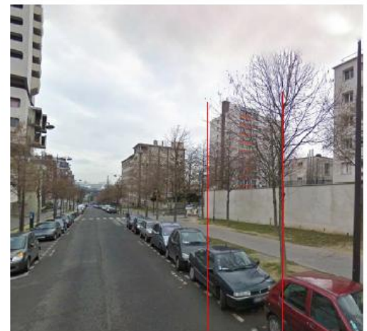
DP 8 - Photo du projet, vue lointaine
