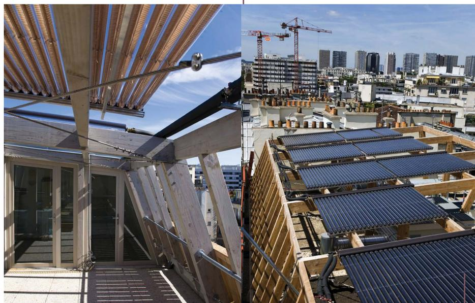
Exemple de mise en œuvre d'une surélévation avec pose de panneaux solaires, Paris 15°
