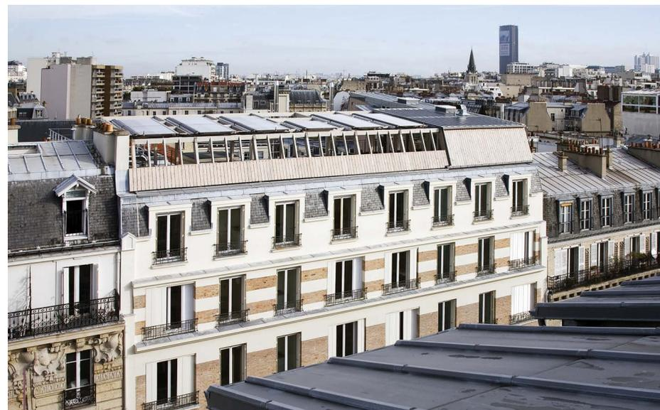
Immeuble réhabilité et surélevé d'un étage avec pose de capteurs solaires, Paris 15<sup>e</sup>
