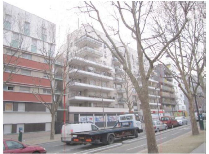
DP 8 - Photo de l'existant, vue lointaine
