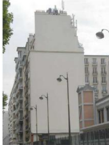
DP 8.1 - Photo de l'existant, vue lointaine
