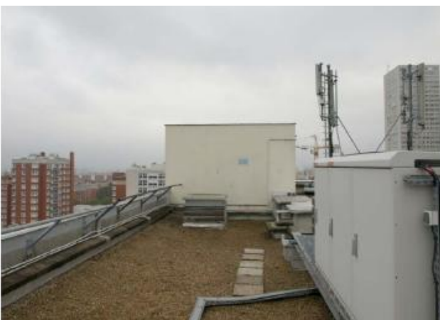
DP 7.2 - Photo de l'existant, détail
