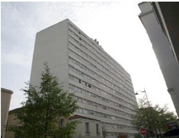
DP 7.1 - Photo de l'existant
