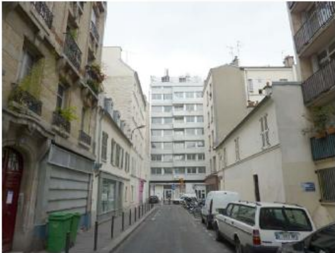
DP 7.1 - Photo de l'existant
