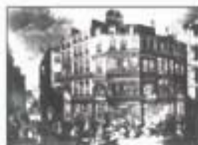
SUPPLÉMENTAIRE CONSTRUCTION DE LA RUE DE RIVOLI
