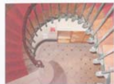
Fiez de chaudière escalier, vue du premier étage
