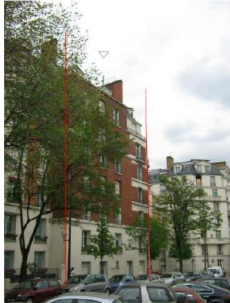
DP 8 - Photo de l'existant, vue lointaine
