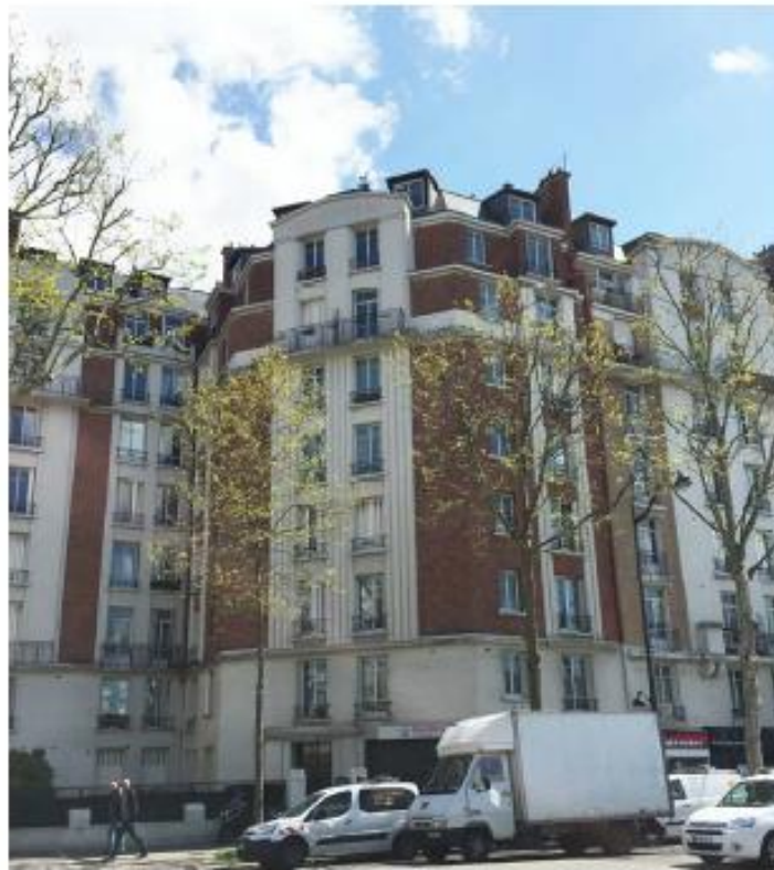
DP 7.1 Photo de l'existant
