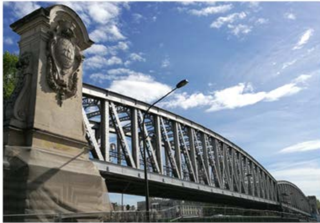
Franchissement Faisceau gare du Nord
