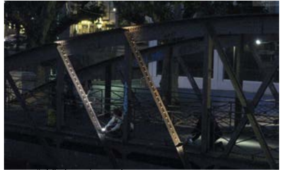
passerelle à Genève, par Luminocité
