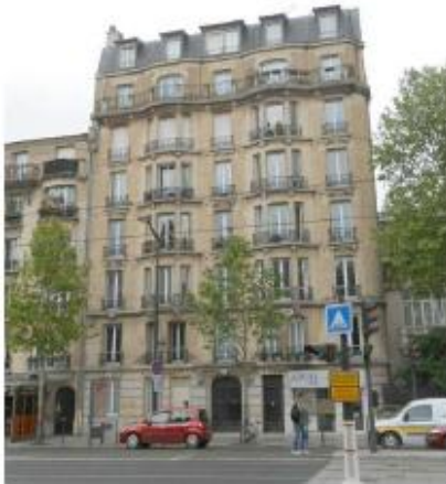
DP 7,1 - Photo de l'existant
