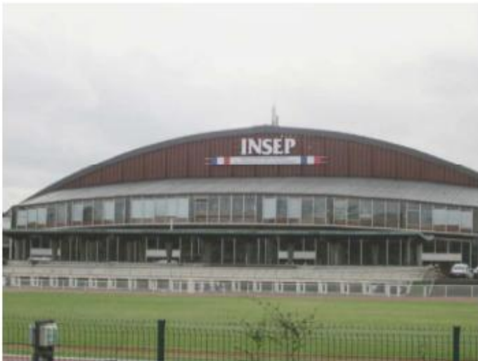
DP 7.1 - Photo de l'existant
