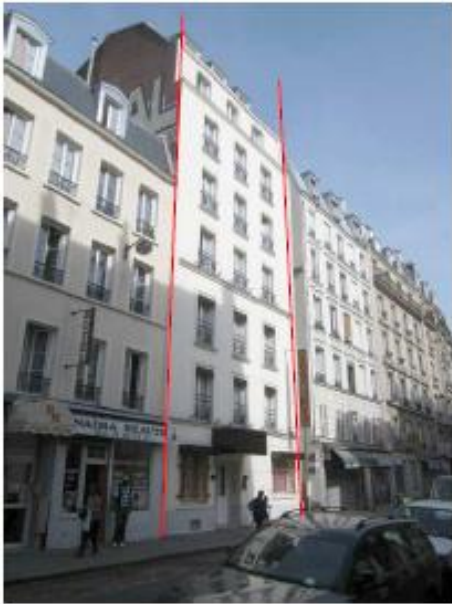
DP 7.1 - Photo de l'existant
