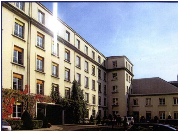
1-FACADE COUR INTERIEURE : EXISTANT
