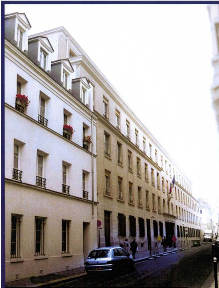
1-FACADE RUE MONSIEUR : EXISTANT
