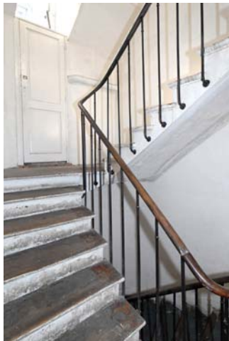
Ci-contre : deux vues de l'immeuble ; l'escalier et la cave côté rue.
