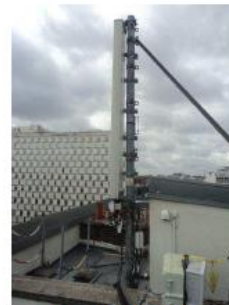
PHOTO AVANT TRAVAUX
