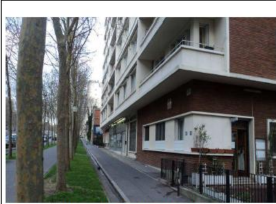
PHOTO DEPUIS LA RUE AVANT TRAVAUX
