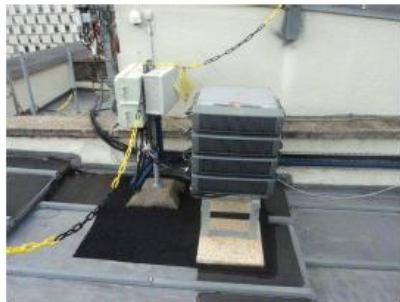
PHOTO AVANT TRAVAUX
