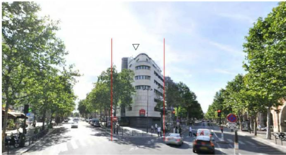
DP 8 - Photo de l'existant, vue lointaine
