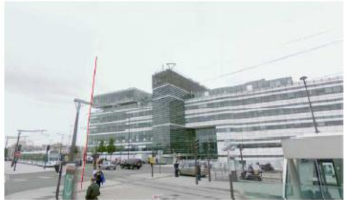
DP 8 - Photo de l'existant, vue lointaine
