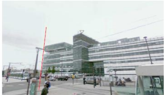
DP 8 - Photo du projet, vue lointaine
