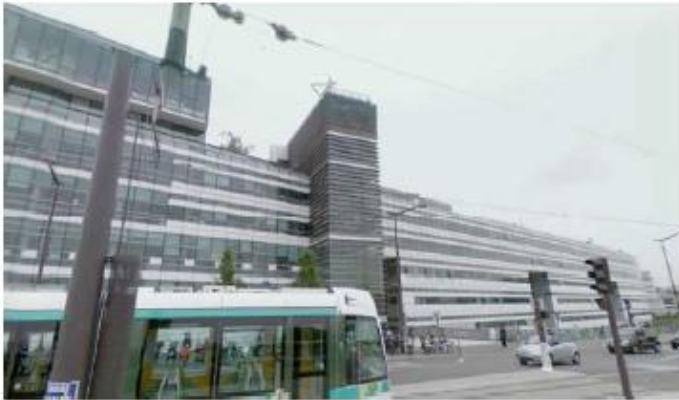
DP 7.1 - Photo de l'existant
