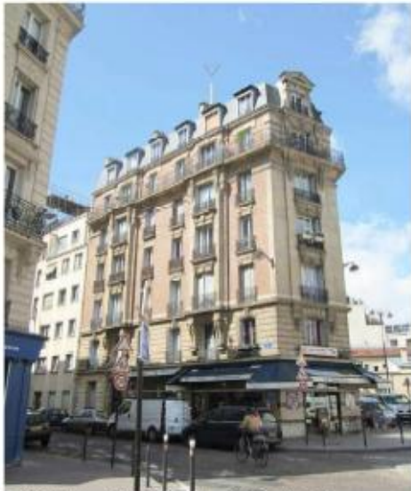
DP 7.1 - Photo de l'existant
