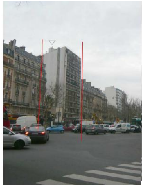
DP 8 - Photo de l'existant, vue lointaine
