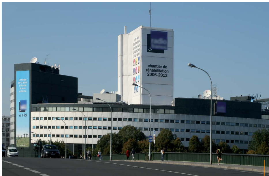
L'eau extraite du bassin de l'Albien alimente l'ensemble du système de chauffage de la maison de la radio
