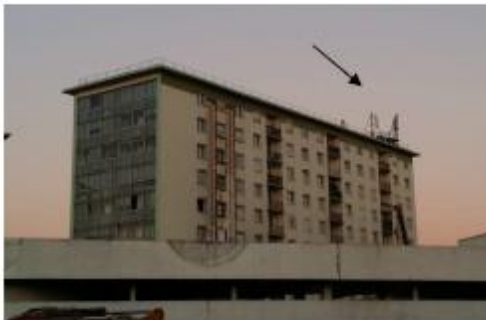
PHOTO DEPUIS LA RUE APRES TRAVAUX (SANS IMPACT VISUEL)
