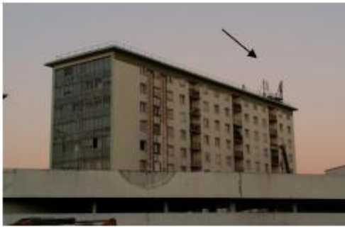
PHOTO DEPUIS LA RUE AVANT TRAVAUX
