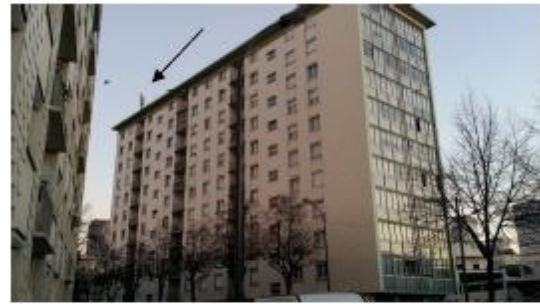
PHOTO DEPUIS LA RUE AVANT TRAVAUX
