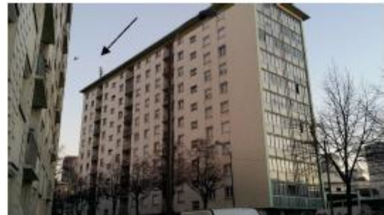
PHOTO DEPUIS LA RUE APRES TRAVAUX (SANS IMPACT VISUEL)
