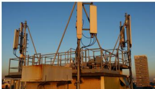
PHOTO AVANT TRAVAUX
