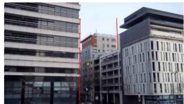
DP 8 - Photo de l'existant, vue lointaine
