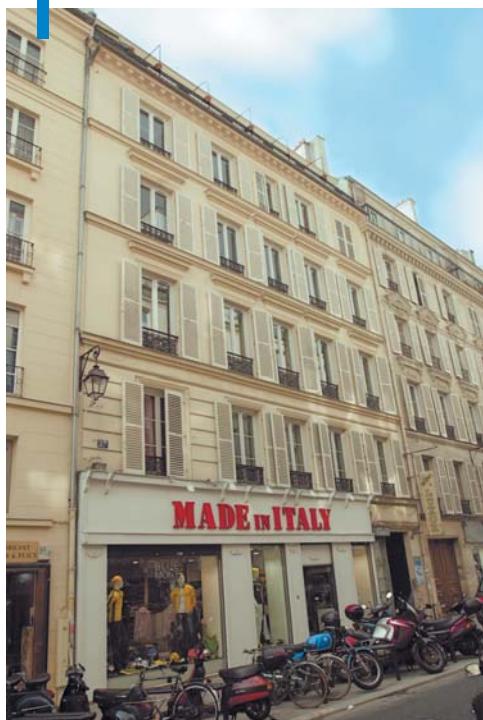
Trente-huit logements réalisés au 37, rue Notre-Dame-de-Nazareth, 3 e arrondissement.
