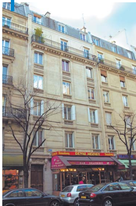
Vingt-sept logements réalisés au 54 bis, avenue Mozart, 16 e arrondissement.
