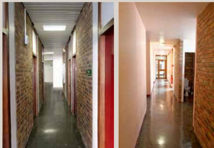
Couloir type dans sa version d'origine au rez-de-chaussée haut et transformée par la mise en place d'un revêtement recouvrant la brique d'origine dans les niveaux supérieurs de l'internat.
