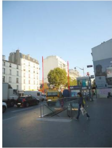
DP 8 - Photo de l'existant, vue lointaine
