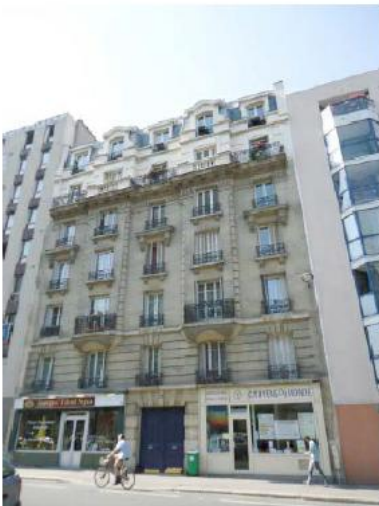
DP 6.1 - Photo du projet (les antennes ne sont pas visibles depuis ce point de vue)
