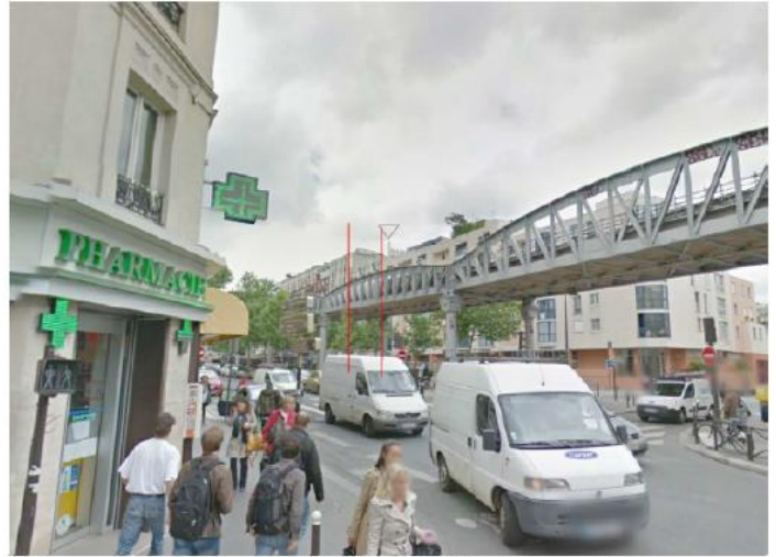
DP 8 - Photo de l'existant, vue lointaine
