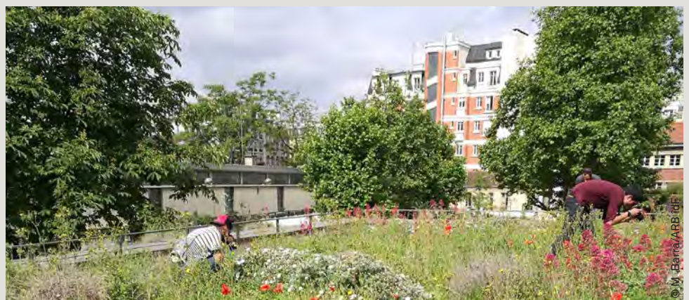
Toiture végétalisée. Groupe scolaire Olivier-de-Serres, à Paris.
