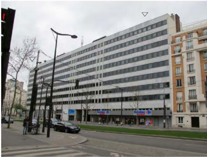
DP 7.1 - Photo de l'existant
