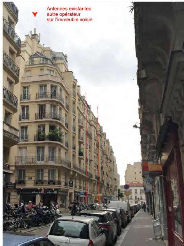
DP. 7.1. Photo de l'existant
