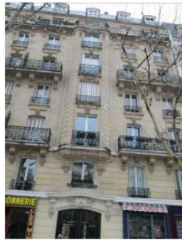
PHOTO DEPUIS LA RUE AVANT TRAVAUX
