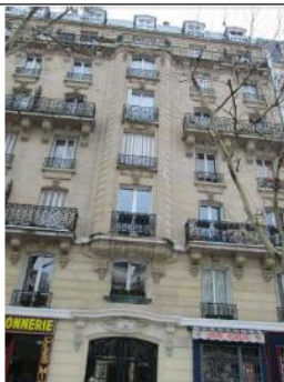
PHOTO DEPUIS LA RUE APRES TRAVAUX (PAS D'IMPACT VISUEL)
