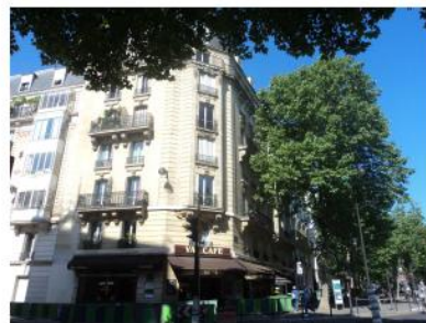
PHOTO DEPUIS LA RUE APRES TRAVAUX (PAS D'IMPACT VISUEL)
