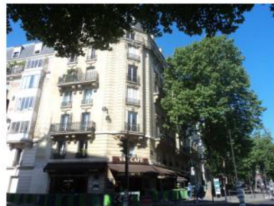
PHOTO DEPUIS LA RUE AVANT TRAVAUX
