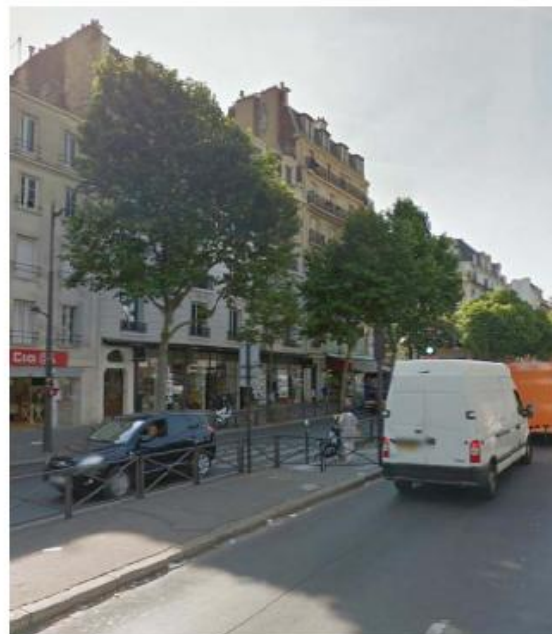
DP 8 - Photo de l'existant, vue lointaine
