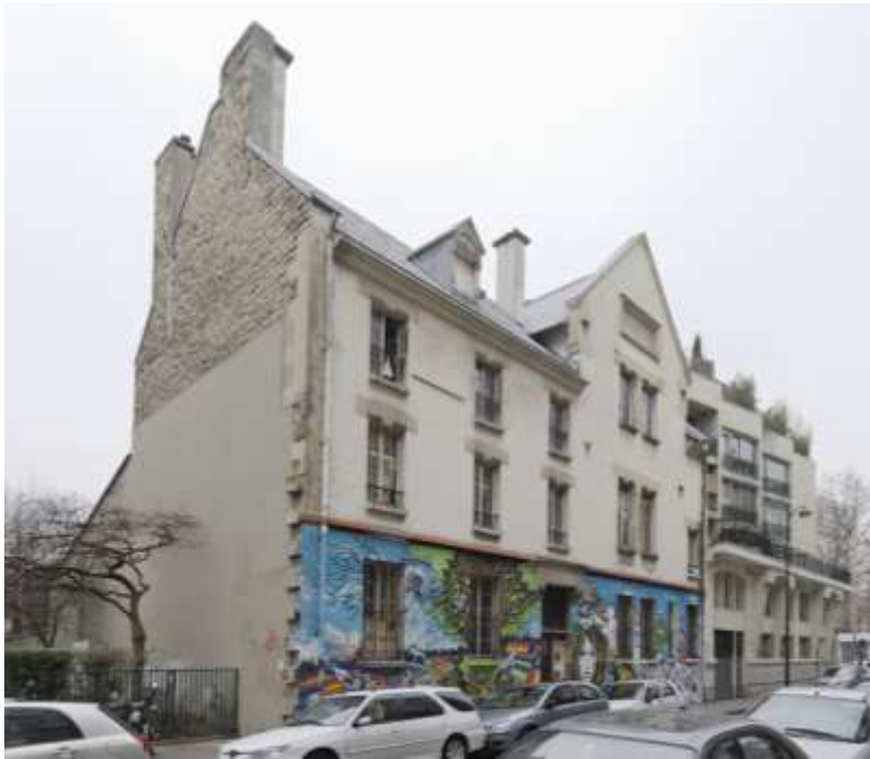
Ci-dessus : PLU, vue actuelle de la façade.
