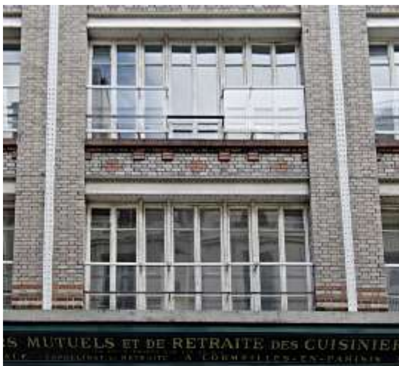
Ci-dessus, de haut en bas : vues actuelles des façades sur la rue Saint-Roch (à gauche) et sur la rue de la Sourdière (à droite) ; détail de la façade sur la rue de la Sourdière.
