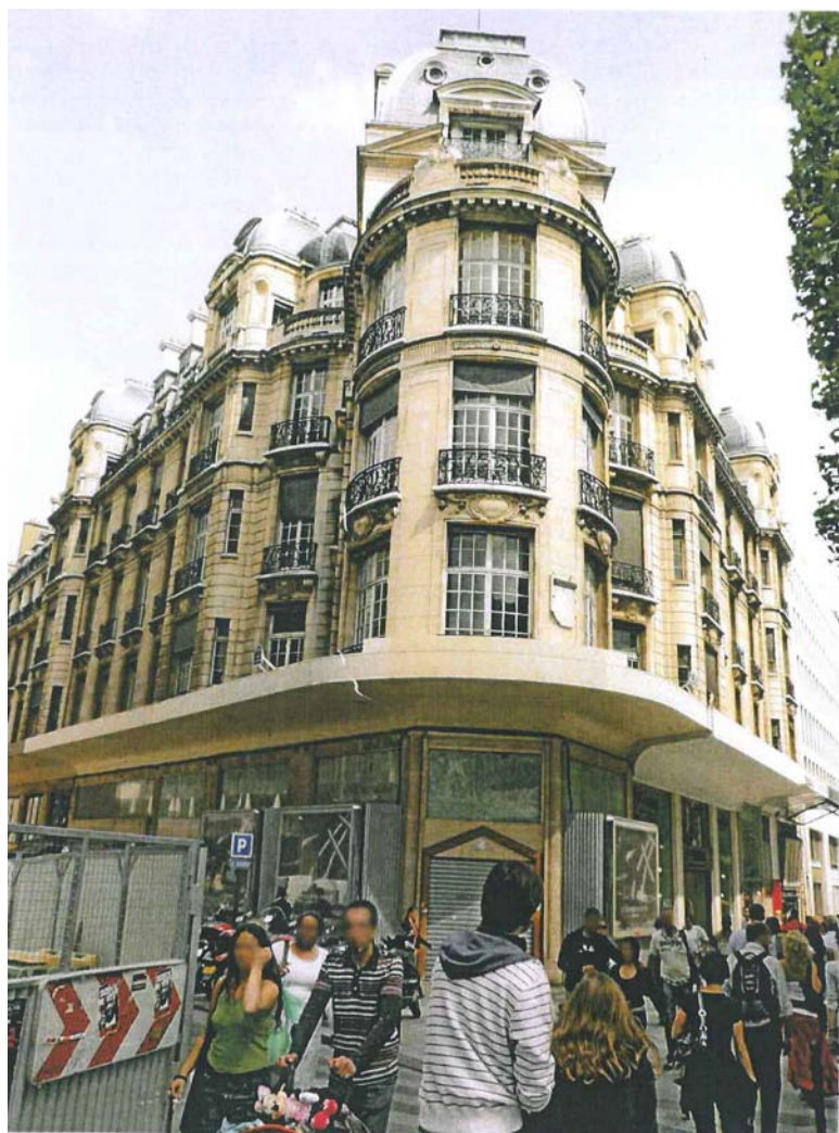
VUE DE PRES EXISTANT
