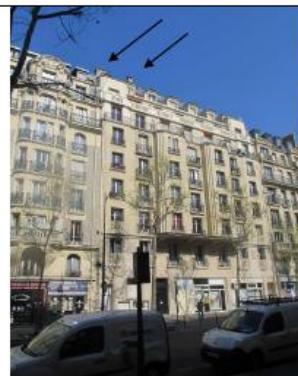
PHOTO DEPUIS LA RUE APRES TRAVAUX (PAS D'IMPACT VISUEL)
