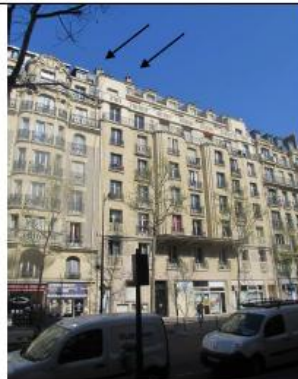
PHOTO DEPUIS LA RUE AVANT TRAVAUX
