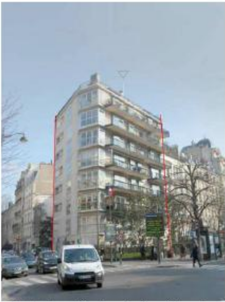
DP 7,1 - Photo de l'existant
