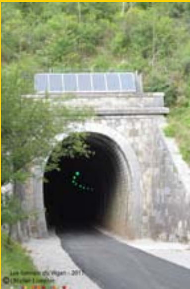
Entrée du Tunnel
