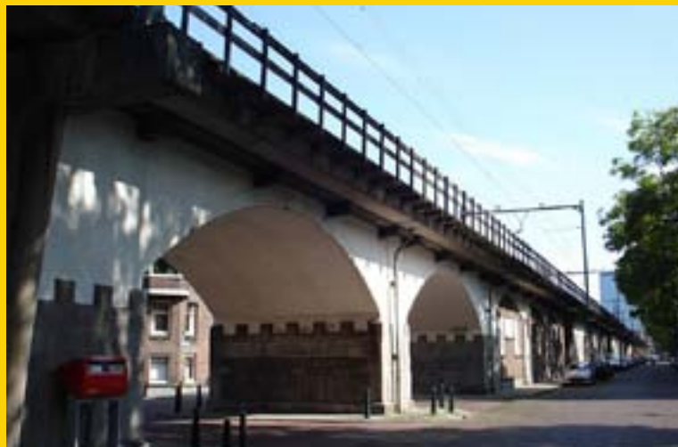
Le viaduc de la Hofpleinlijn (Source : Wikimedia Commons)
