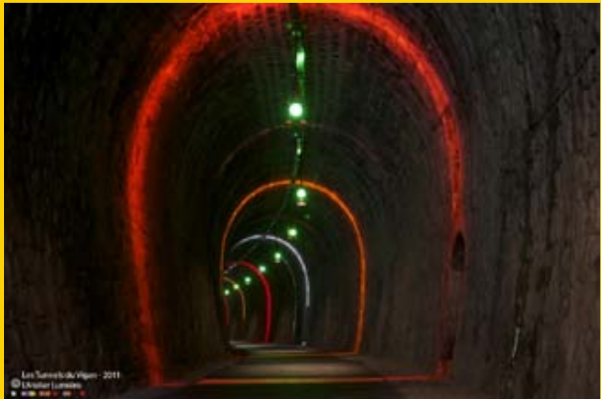
Intérieur du Tunnel
