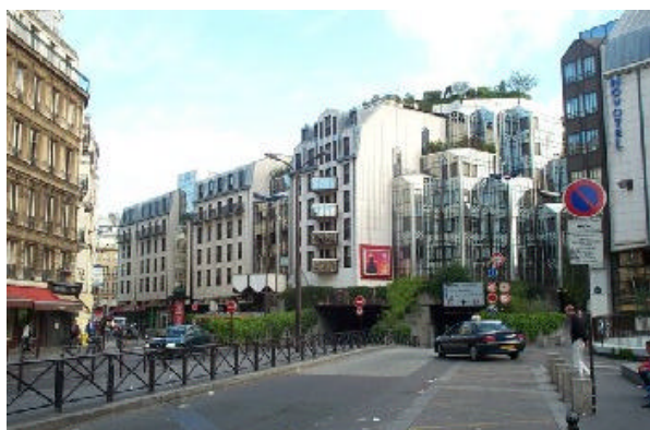
Le trémie de la rue des Halles, séparant les zones Est et Sud.
