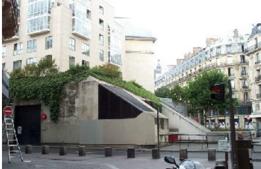
La sortie du tunnel rue de Turbigo
